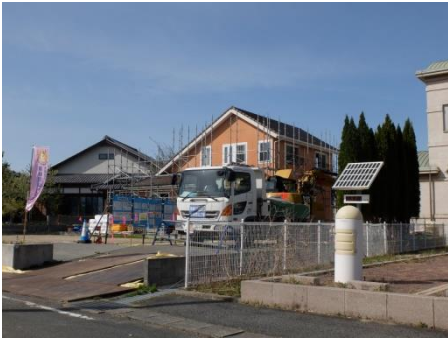
図書館近くの家屋解体
