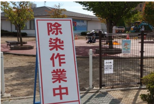
2014. 9. 26 除染作業の看板
