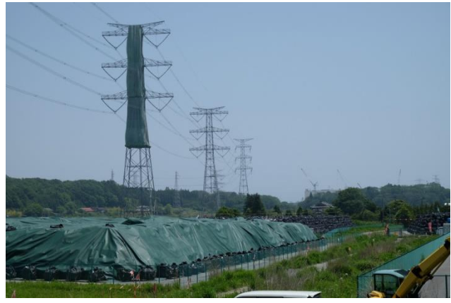
中間貯蔵施設（大熊町）
